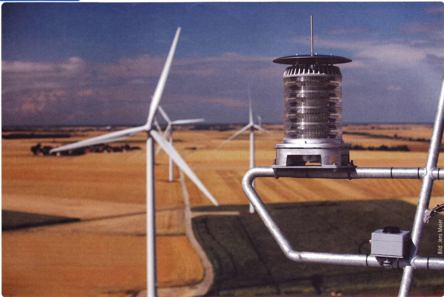
Bild 1: Intensitätsregelung von Gefahrfeuern in Windparks.
